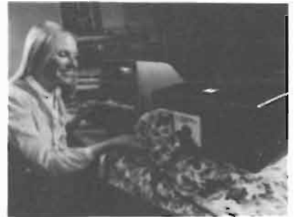
Fig. 4 - Il Colour Match Prediction System prodotto in U.K. è un apparato assai più complesso, ma completamente automatico che esegue due funzioni basilari: analizzare le tinte e determinarne la gradazione.
